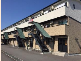
新設した外国人専用の寮 (外観)
