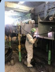
溶接作業の様子
